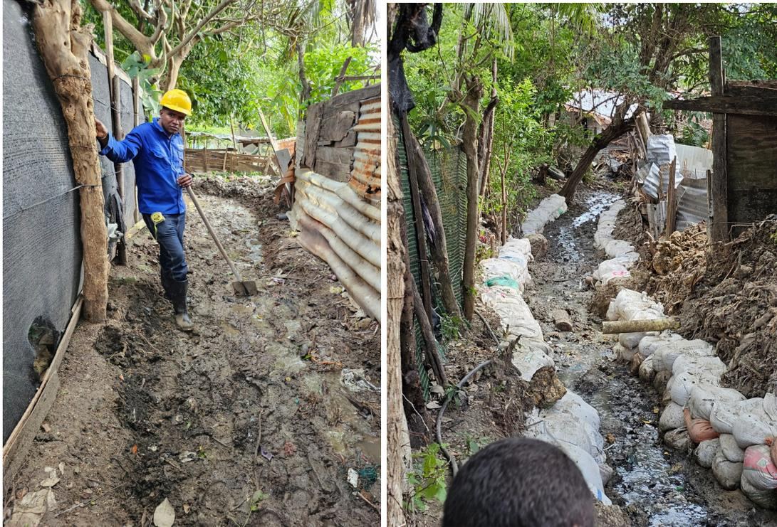
ILUSTRACIÓN 4 EXCAVACIÓN Y PROTECCIÓN DEL ARROYO
